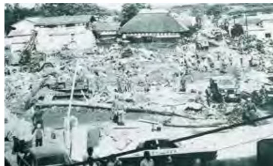
土石流が民家を巻き込みながら流れた後の百沢地区(1975年8月) 写真提供:弘前市
