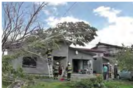
樹木が根こそぎ倒れ、住宅にもたれかかる(高杉地区)
